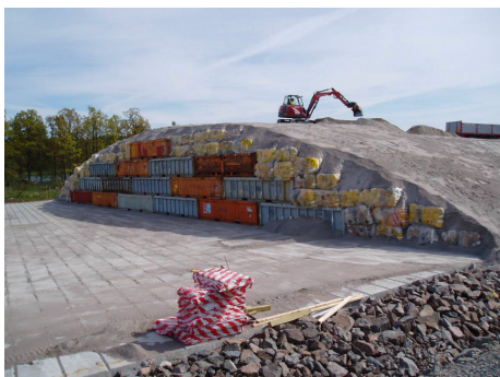
Bild på markförvaret vid Oskarshamns kärnkraft 1
